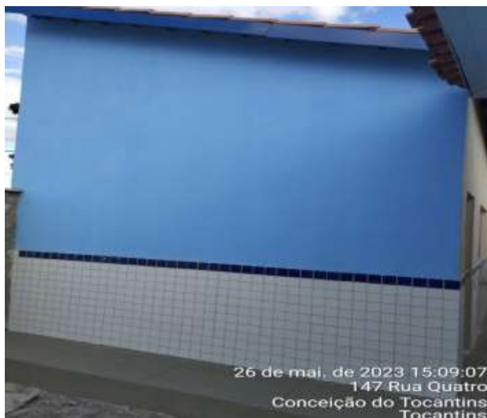
Figura 03: Construção de 2 salas de aulas na escola Sadja Samara.
