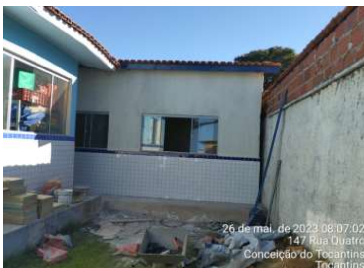
Figura 07: Construção de 2 salas de aulas na escola Sadjá Samara.
