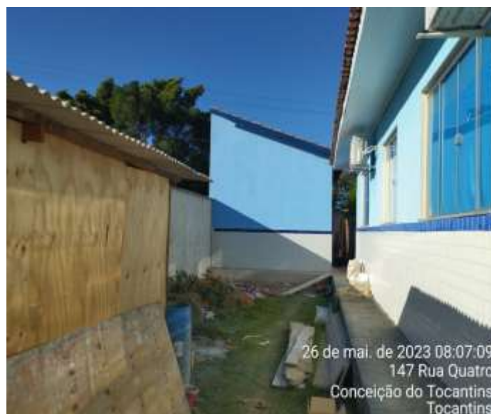
Figura 06: Construção de 2 salas de aulas na escola Sadjá Samara.
