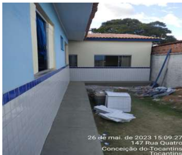
Figura 02: Construção de 2 salas de aulas na escola Sadja Samara.
