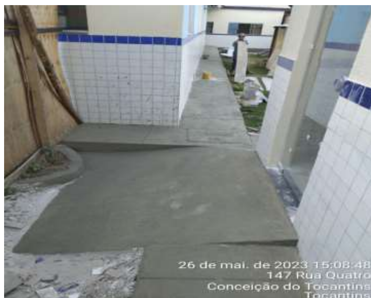
Figura 05: Construção de 2 salas de aulas na escola Sadjá Samara.
