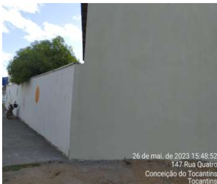
Figura 01: Construção de 2 salas de aulas na escola Sadja Samara.
