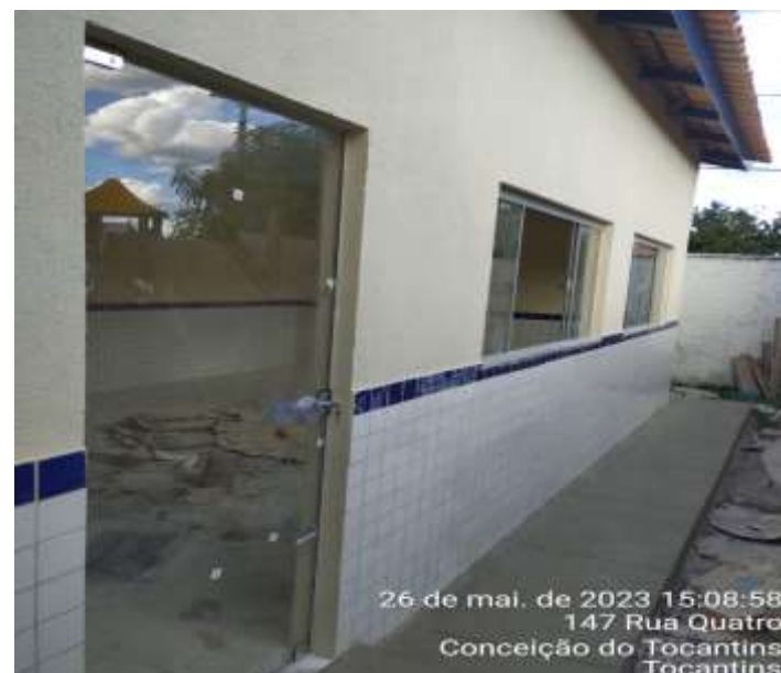
Figura 04: Construção de 2 salas de aulas na escola Sadja Samara.
